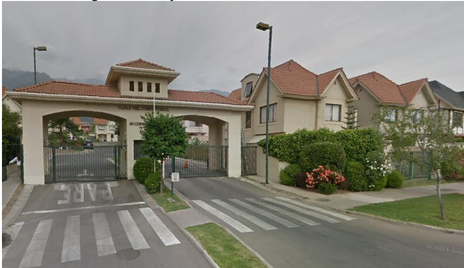
Figura N°14: Conjunto de viviendas Casas del Consistorial.
