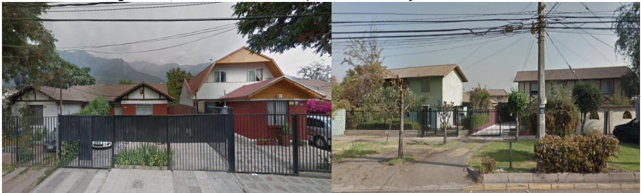
Figura 25: Edificaciones de uno a tres pisos de altura. Conjunto El Mirador de Tobalaba
