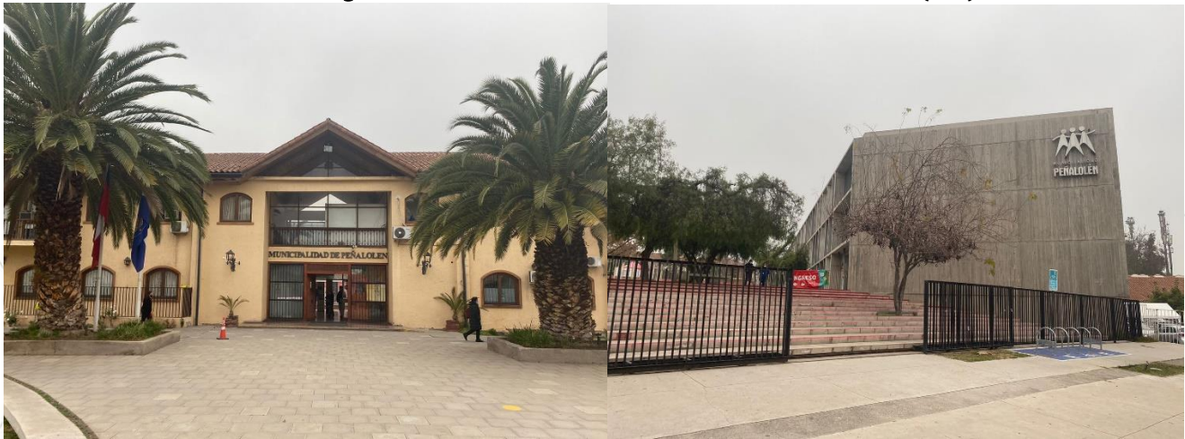
Figura 21: Casona Consistorial – Centro de Atención al Vecino (CAV)
