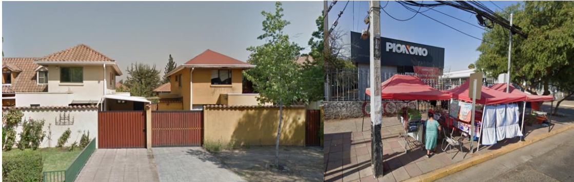
Figura 28: Edificaciones de uno a dos pisos de altura. Conjunto El Faro de Peñalolén
