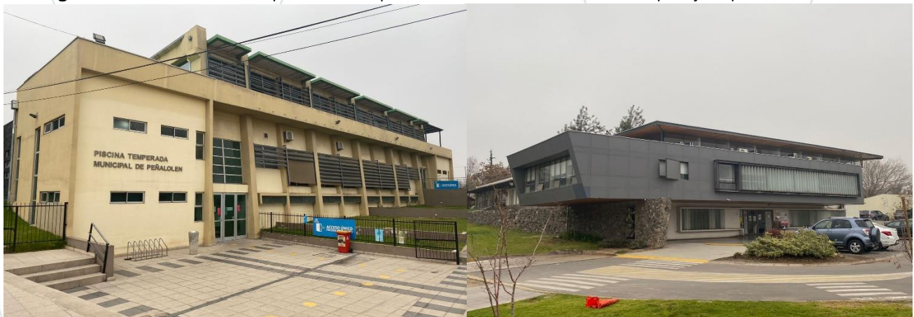
Figura 23: Edificio Piscina Temperada Municipalidad de Peñalolén – Centro de Empleo y Emprendimiento Yunus
