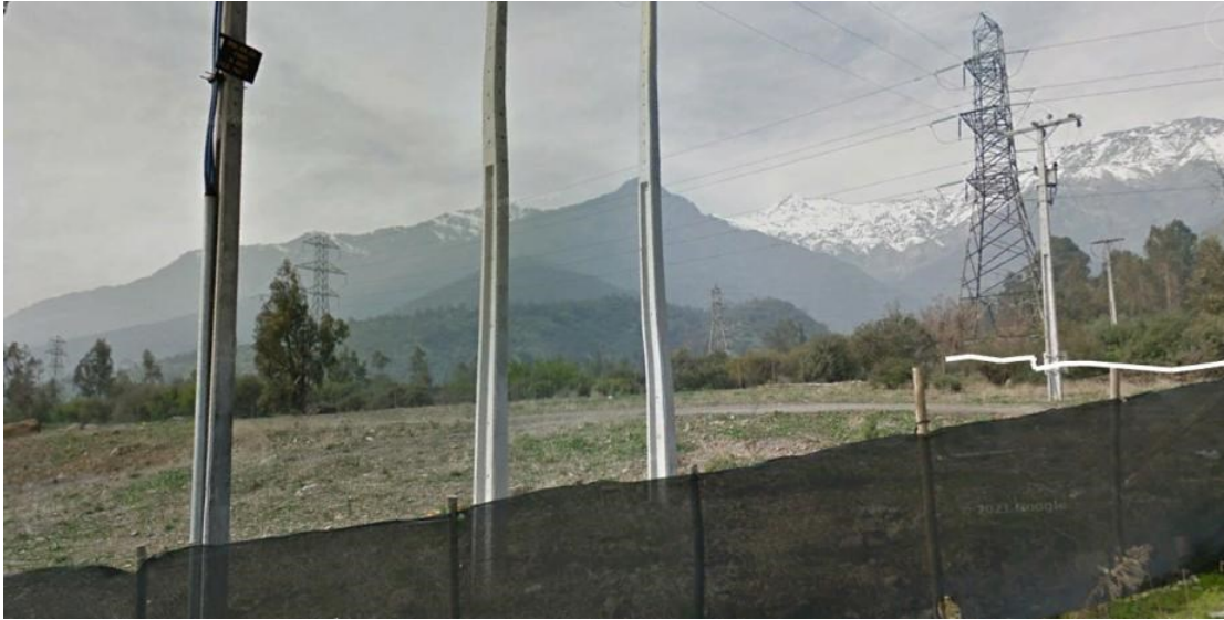
FIGURA N° 2-8 Líneas de Alta Tensión de 220 KV en Av. Quilín
