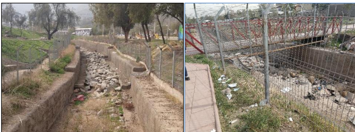
FIGURA C-7 Quebrada Lo Hermida canalizada aguas abajo del cruce con Avenida Diagonal Las Torres.
