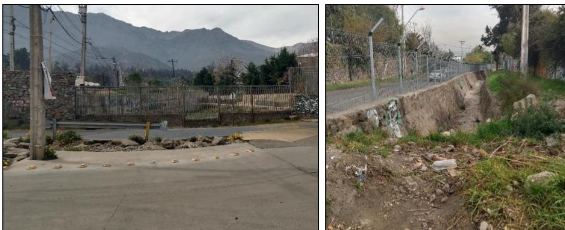
FIGURA C-4 Cruce Quebrada Nido de Águilas en badén calle Álvaro Casanova (izquierda) y canalización hacia aguas abajo (derecha).
