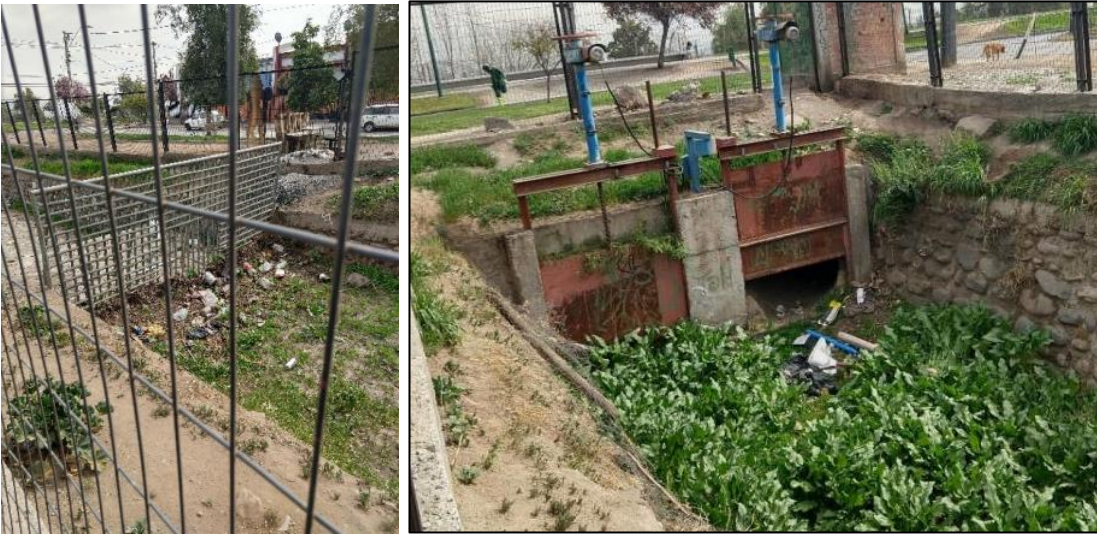
FIGURA C-9 Quebrada Lo Hermida en punto de descarga al canal Las Perdices.
