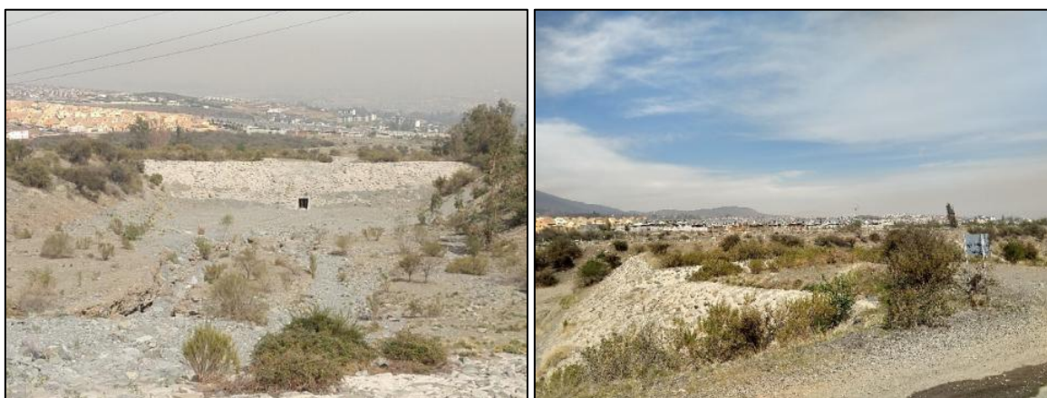
FIGURA C-12 Obras en Quebrada Macul.
