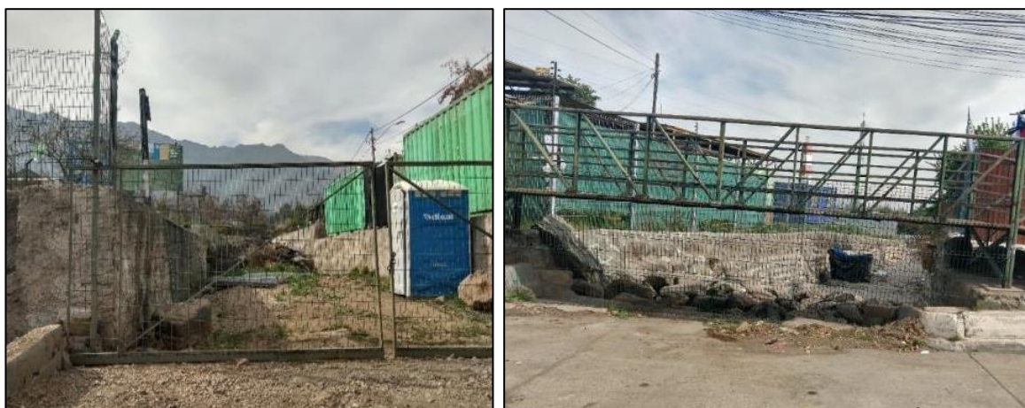
FIGURA C-5 Canalización aguas arriba de la calle Caballero de la Montaña (izquierda) y aguas abajo (derecha).
