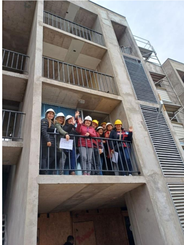
Figura 67: Construcción torre de conjunto habitacional Altos del Parque.
