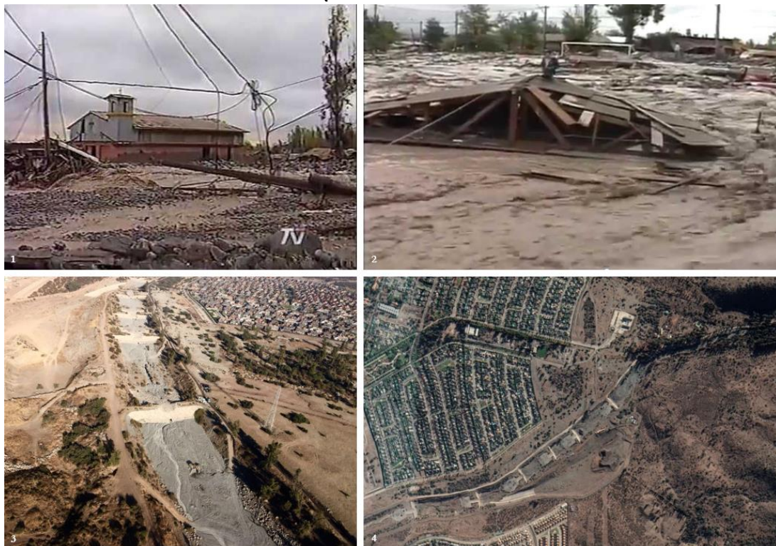
Figura N° 2: 1) y 2) Desastres tras el aluvión 1993 en Quebrada de Macul, Peñalolén, 3) y 4) piscinas de decantación en Quebrada de Macul.
