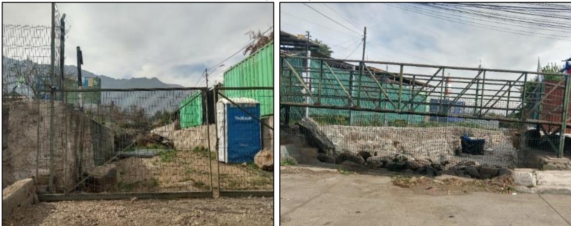
Fuente: Fotografías visita a terreno 04/09/2019
