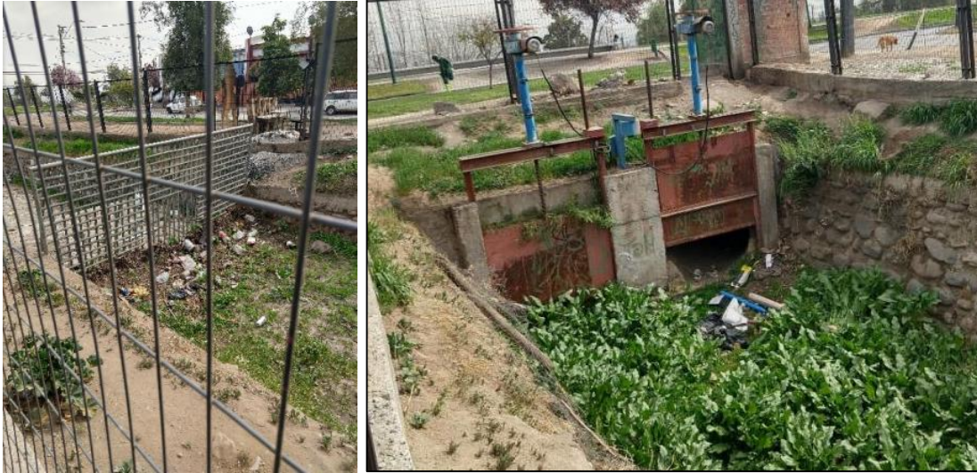
FIGURA ANEXO N° 8-24: Quebrada Lo Hermida en punto de descarga al canal Las Perdices.
