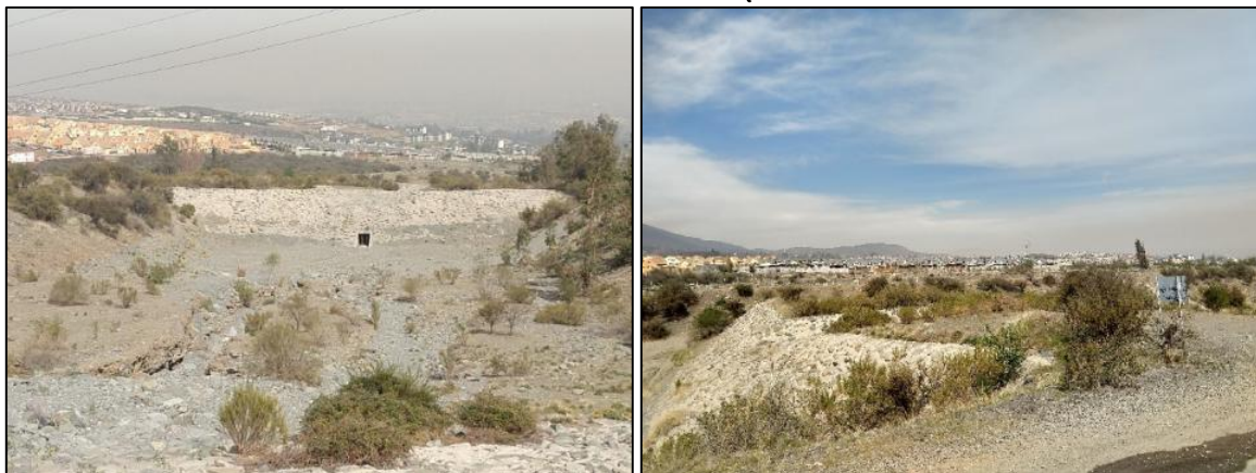
FIGURA ANEXO N° 8-27: Obras en Quebrada Macul.
