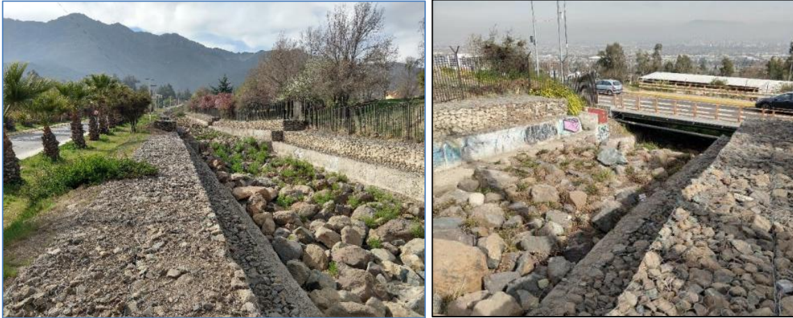
FIGURA ANEXO N° 8-17: Canalización quebrada Peñalolén paralela a Av. Las Palmas (izquierda) y puente en cruce con calle Álvaro Casanova (derecha).
