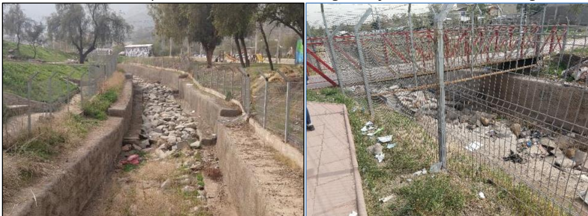
Fuente: Fotografías visita a terreno 04/09/2019.
