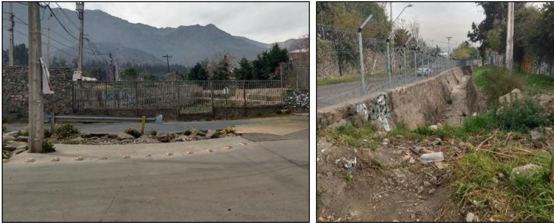
FIGURA ANEXO N° 8-19: Cruce Quebrada Nido de Águilas en badén calle Álvaro Casanova (izquierda) y canalización hacia aguas abajo (derecha).
